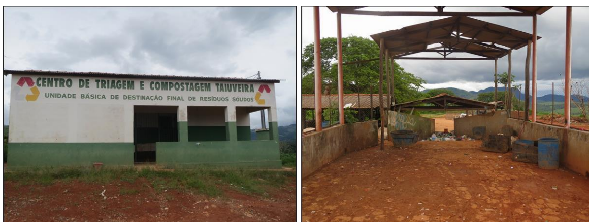
Figura 3.2: Usina de Triagem e Compostagem. Área destinada aos funcionários (banheiros, vestiários e refeitórios) e área onde são depositados os resíduos assim que chegam à usina.
