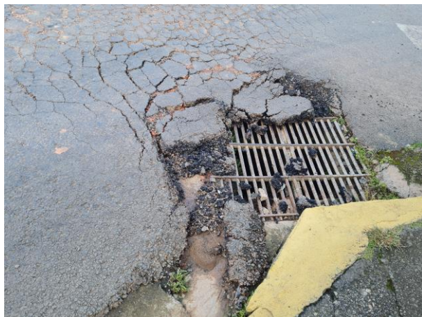
Foto 08: Asfalto danificado junto à boca de lobo.
