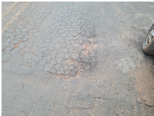
Foto 88: Detalhe de asfalto totalmente danificado.
