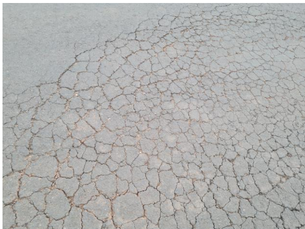
Foto 82: Detalhe de buraco e asfalto totalmente danificado.
