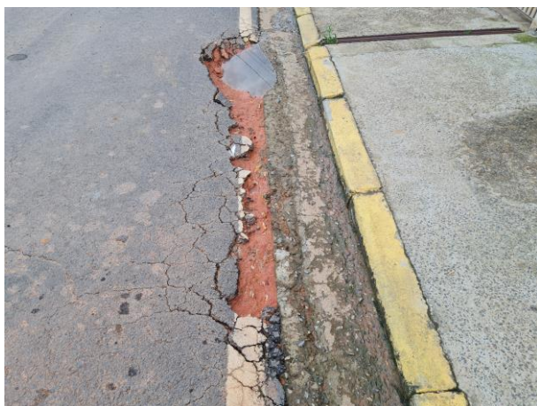
Foto 51: Buraco junto à sarjeta.
