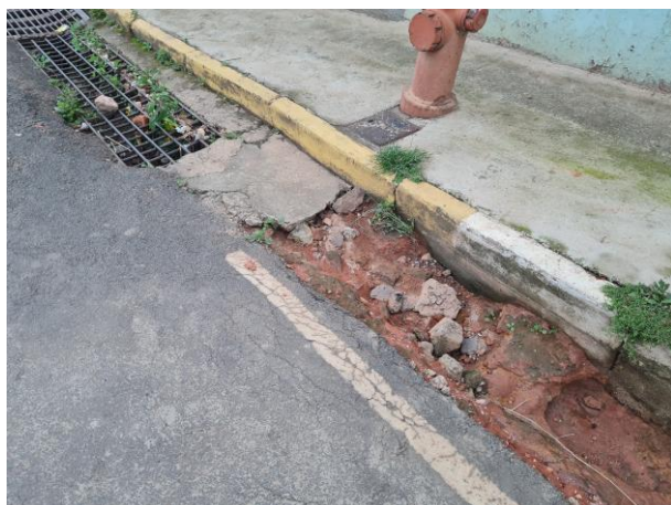
Foto 84: Detalhe de buraco e asfalto totalmente danificado.
