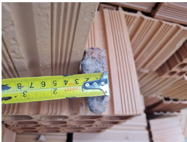
Foto 66: Apenas 2,0 cm de camada de asfalto.
