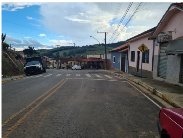
Foto 87: Em toda a extensão do asfalto há trincas e buracos. O asfalto encontra-se totalmente danificado.
