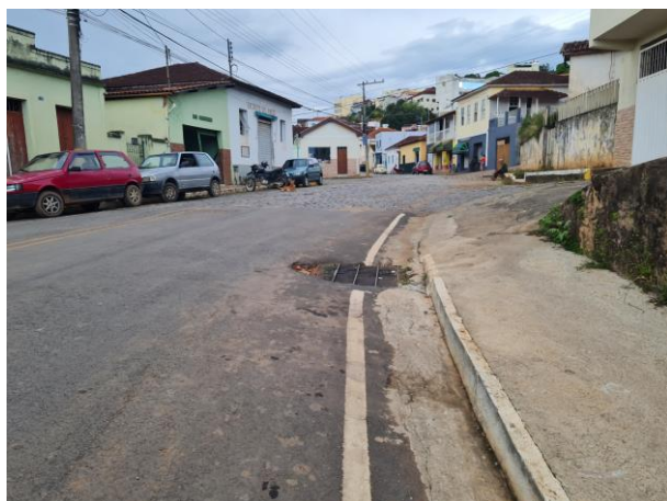
Foto 88: Detalhe de asfalto totalmente danificado.
