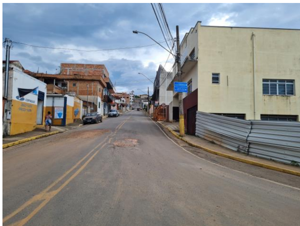
Foto 68: Em toda a extensão do asfalto há trincas e buracos. O asfalto encontra-se totalmente danificado.
