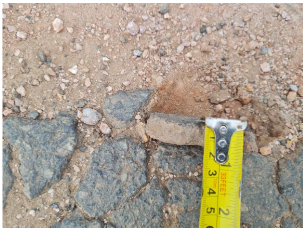
Foto 76: Detalhe de camada de asfalto com 1,5 cm de espessura.
