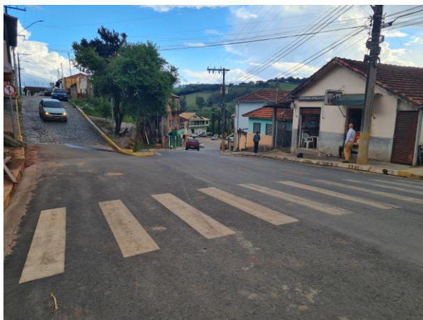
Foto 77: Em toda a extensão do asfalto há trincas e buracos. O asfalto encontra-se totalmente danificado.
