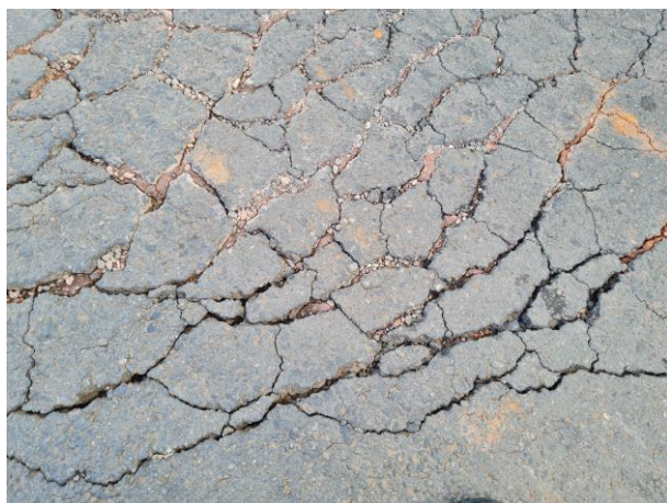
Foto 08: Asfalto danificado junto à boca de lobo.
