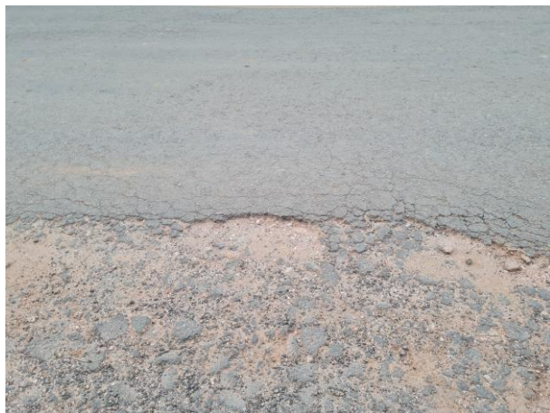
Foto 84: Detalhe de buraco e asfalto totalmente danificado.
