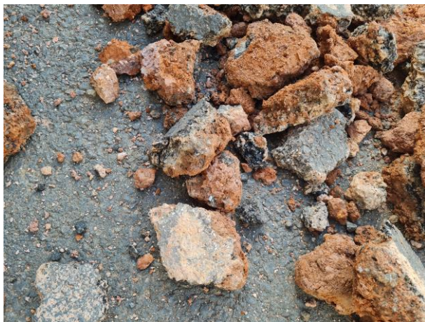
Foto 05: Detalhe da espessura do asfalto retirado do local, 3cm.
